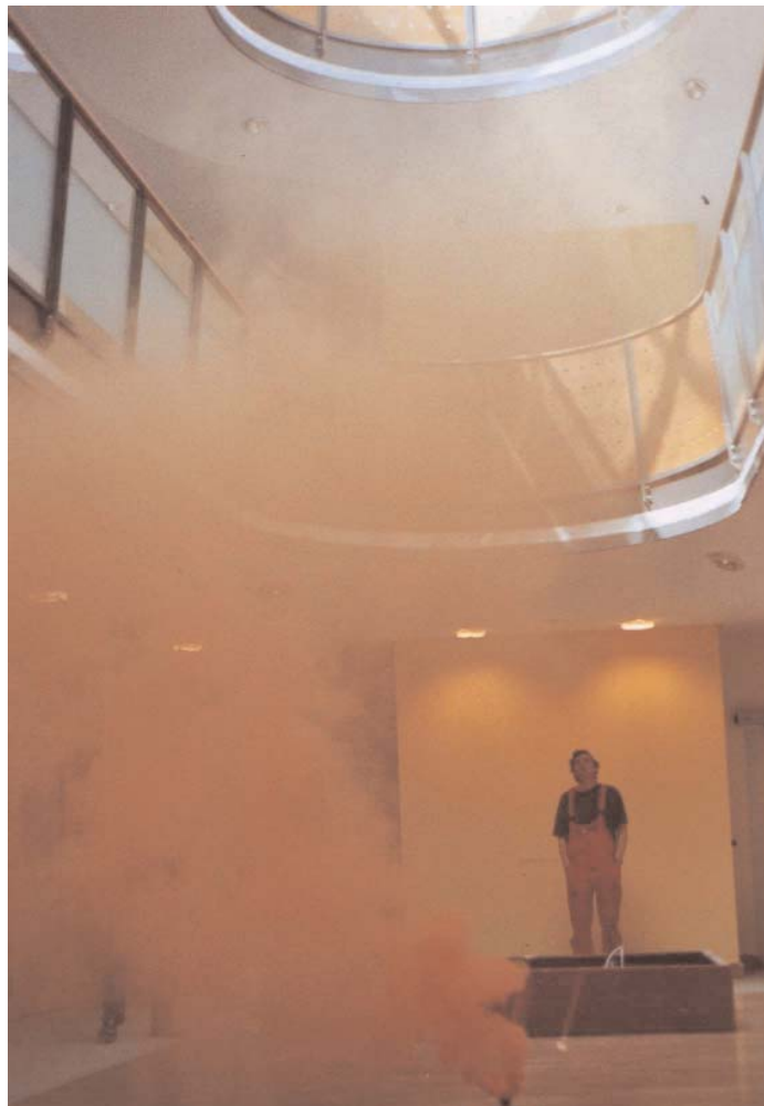
Rauchversuch zur Überdruckbelüftung im Atrium
