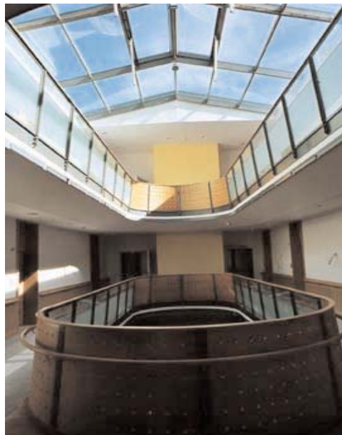
Entrauchungsklappen im Oberlicht des Atriums.
